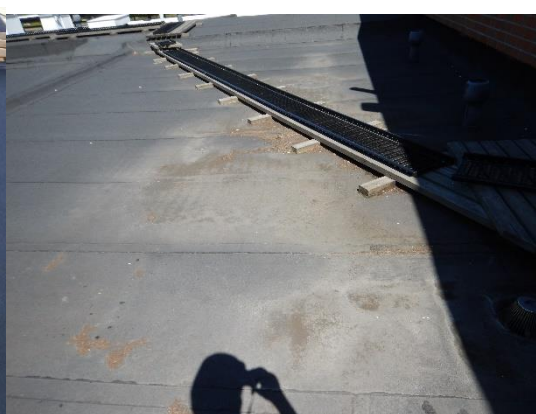
Kuva 6: Kulkusiltojen alle kertynyttä roskaa
