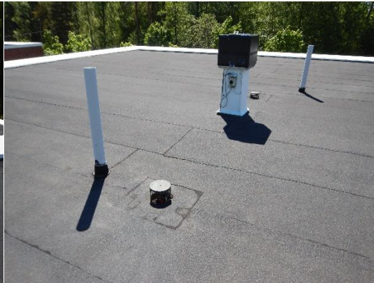
Kuva 2: Kattokaivojen hyvä toiminta ja korkoasema
