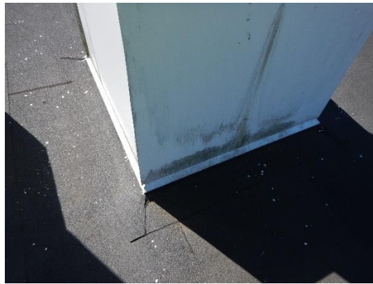
Kuva 8: Liitosten kermitys ja pellitys.
