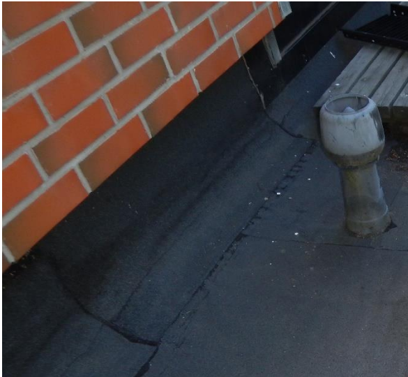
Kuva 5: Kermin ylösnosto seinän vierillä.
