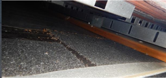
Kuva 6: Ylösnosto seinärakenteen sisällä
