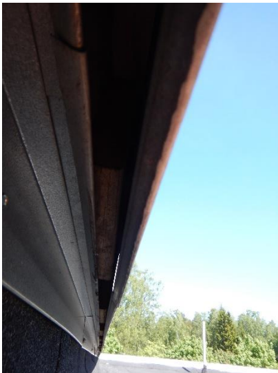
Kuva 3: räystäspellin tuuletusrako ja myrskypeltti
